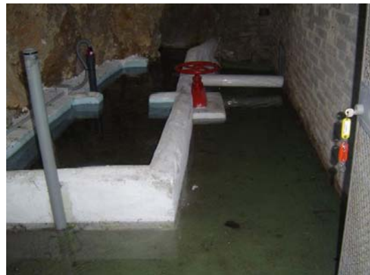
Foto 7.6.- Manantial del Xorrador (293250020): Salt San Cristóbal.
